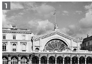
la gare de l'Est
